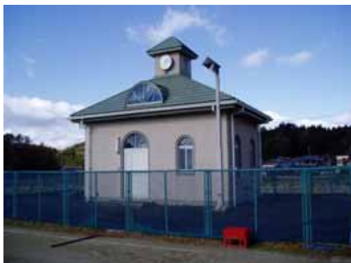
「橋場加圧ポンプ場」
