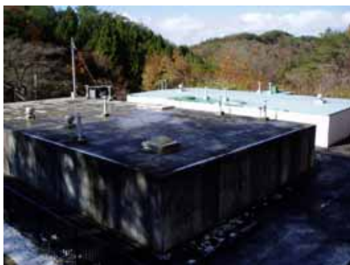
「乙空釜配水池 手前の施設が増設配水池」
