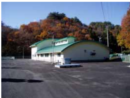
「乙空釜浄水場（第 2 水源系）手前の施設は乙空釜第 2 水源」
