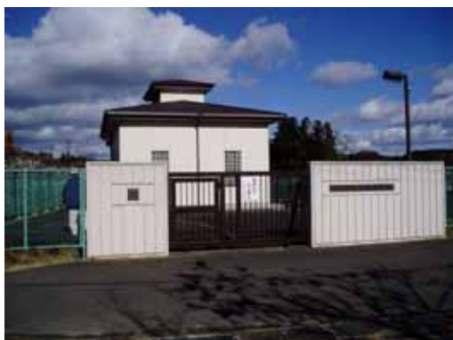
「新田前加圧ポンプ場」
