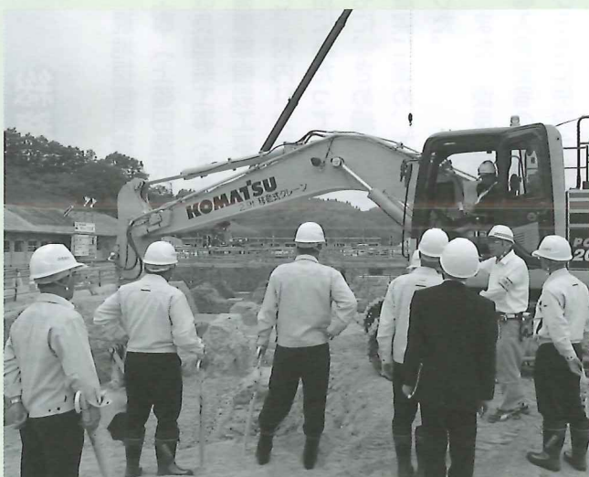
△工事が進行中のひらた清風中学校建築現場
