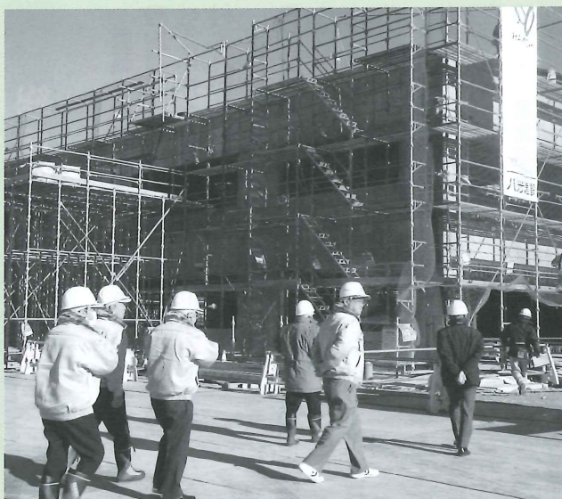
△ひらた清風中学校校舎建築工事状況の視察
