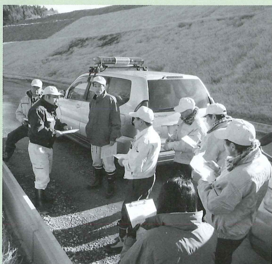
△ひらた清風中学校配水管及び排水布設工事現場で説明を受ける総務経済常任委員会委員
