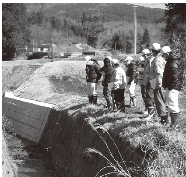
河川災害（沢又川）の復旧工事
