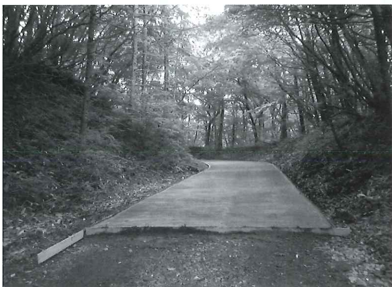
今年度前期分として290mの舗装工事が完了した
