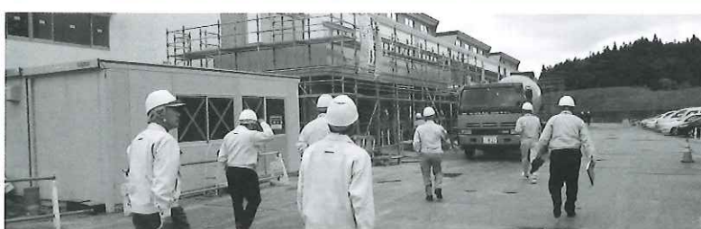
中学校建築工事の視察
