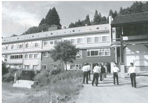
▲廃校舎を宿泊施設に改修
