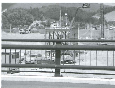
▲被災した旧防災対策庁舎
