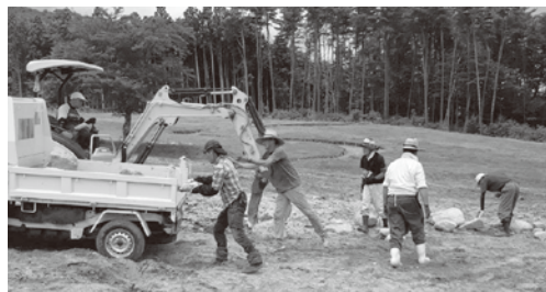
ジュピアでの作業の様子
