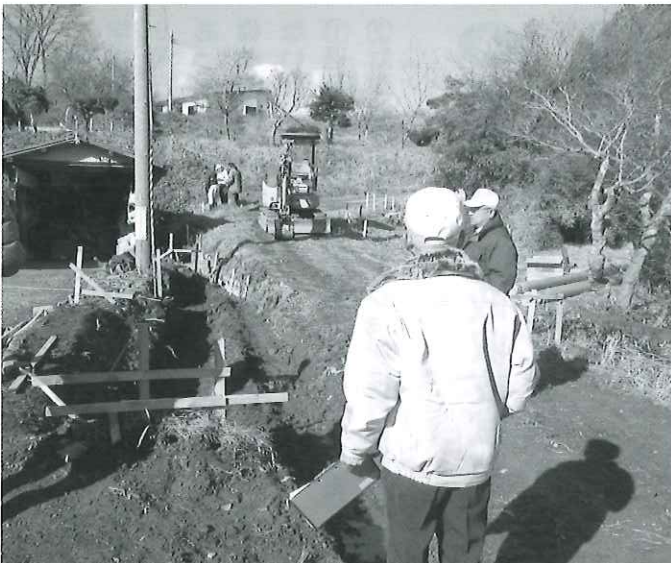
村道1068号線道路改良舗装工事(上蓬田字清水内地内)
