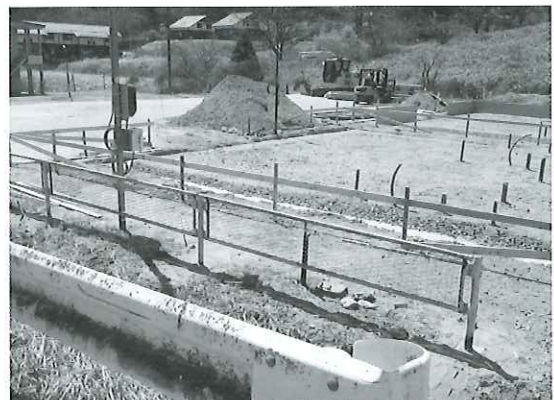
切山住宅跡地に民間賃貸住宅建設が進む
