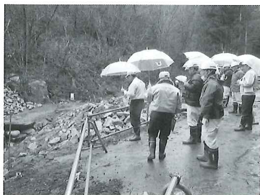
村道草場乙空釜線12号橋更新工事 (西山字煙石地内)
