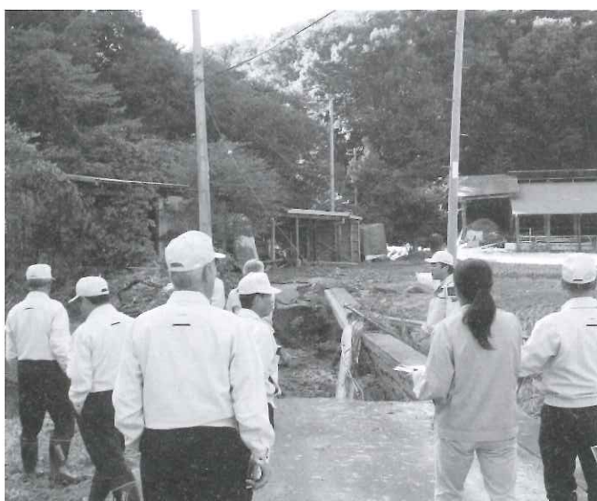
10月16日 議会全員協議会において視察 (西山地内 村道真弓千保線)
