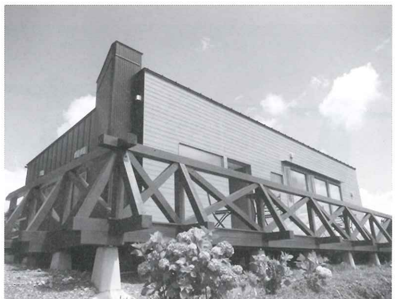
6月12日に完成した多目的休憩施設
