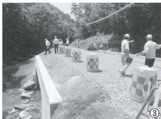
◀③村道草場乙空釜線12号橋更新工事の状況を視察。
