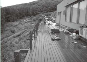
ウッドデッキ拡張工事
