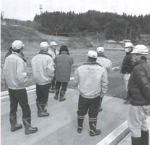
▲村道1065号線道路改良工事の現地視察(上蓬田字馬道地内)
