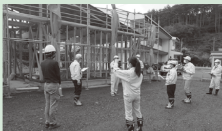
小平地区公衆トイレ・休憩所建築工事
