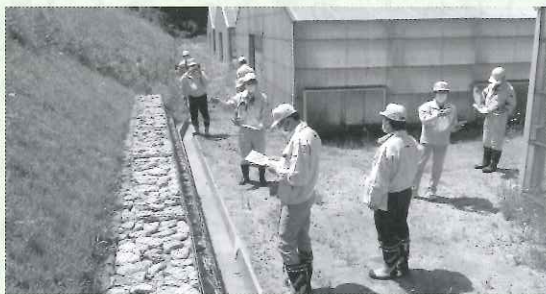
平田たばこ育苗センター法面復旧工事 (北方字後川)
