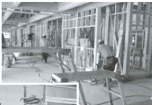
▲建物内部の様子
