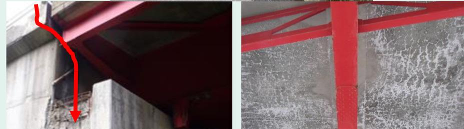
路面のひび割れから水が浸透したり、伸縮装置の隙間から雨水がパラペットを伝って流れたりすることで、床版や桁端部の劣化につながる
