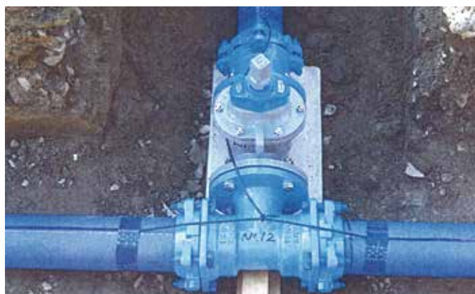
配水管布設替工 仕切弁設置
