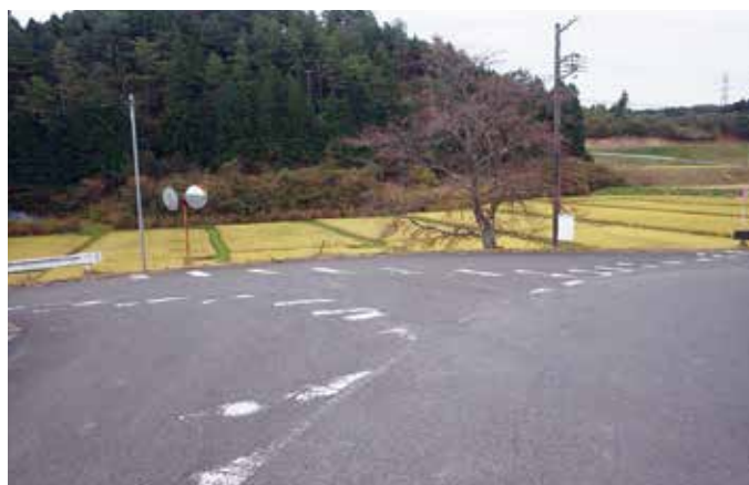
駒形字長岡地内（施工前）
