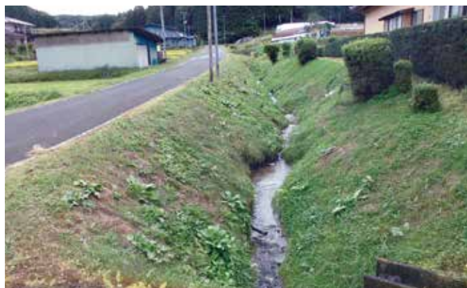
北方字羽貫田地内（施工前）
