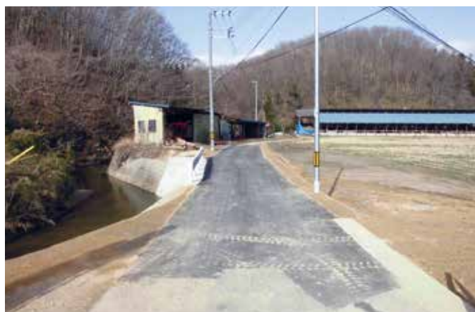
村道真弓千保線（施工後）
