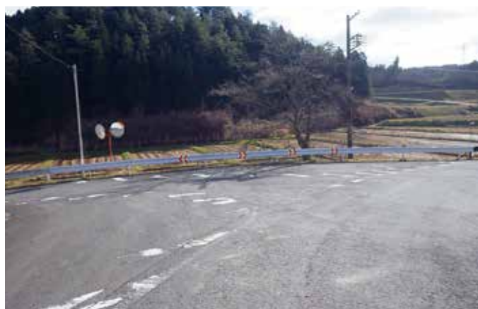
駒形字長岡地内（施工後）
