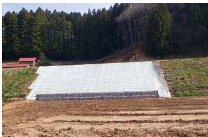
九生滝字小綱木地内（施工後）
