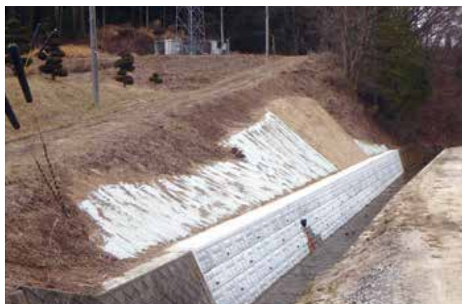
堂作川（施工後）
