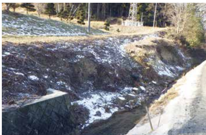
堂作川（施工前）
