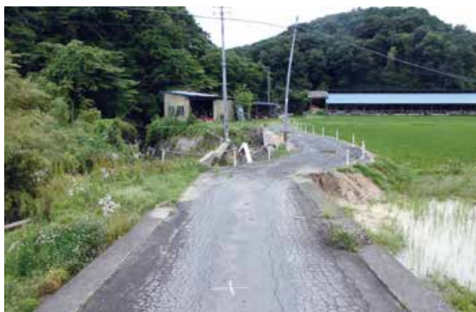
村道真弓千保線（施工前）
