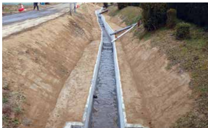
北方字羽貫田地内（施工後）
