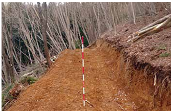
作業道（上蓬田字上宿地内）
