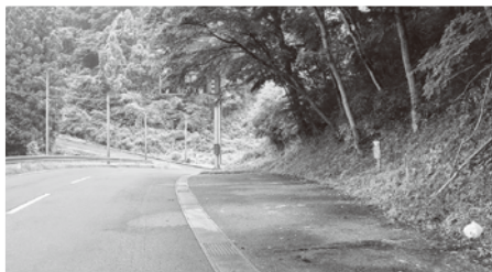
村道清水・草場線(西山字草場地内の待避所)
