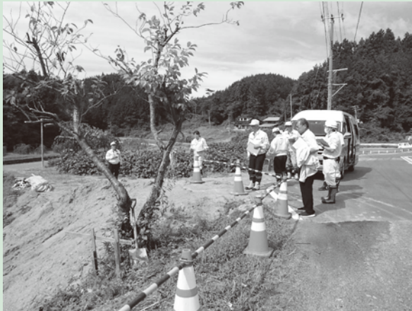
村道真弓千保線道路改良工事（中倉字川面地内）
