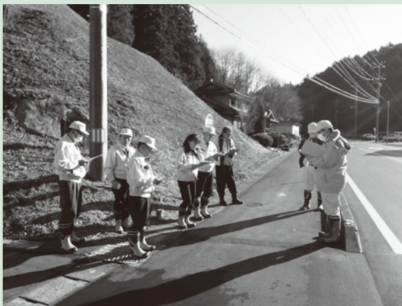
村道鴛子後川線道路舗装修繕工事 （永田字酒舩地内）
