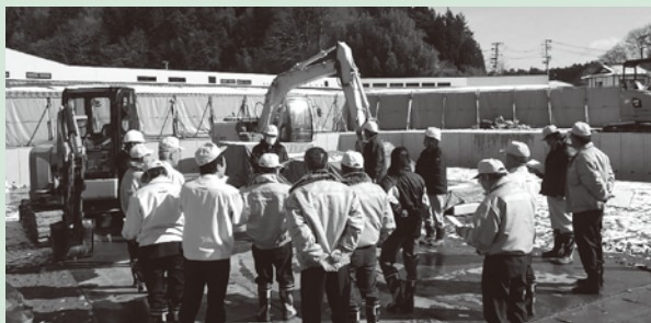
よもぎ荘増築敷地造成工事
