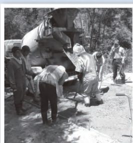
生コン舗装支給事業
