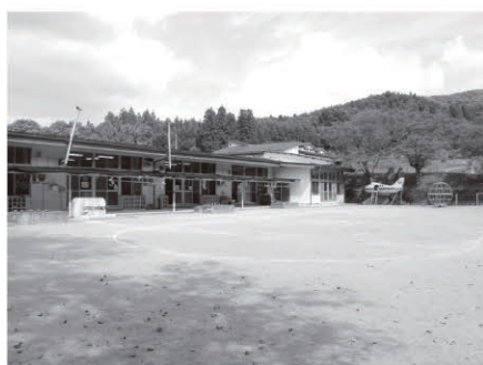
蓬田こども園 (旧蓬田保育所: 昭和46年建築)
