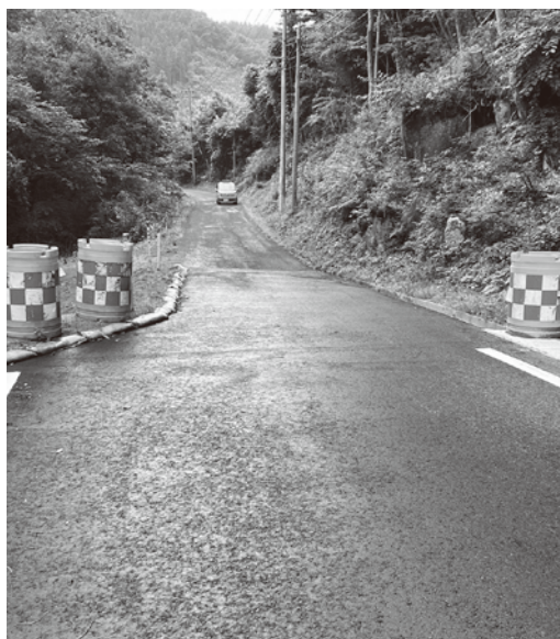
改良工事予定の村道草場乙空釜線
