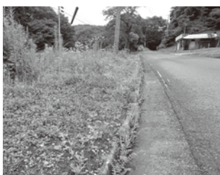
歩道に草が繁茂している
