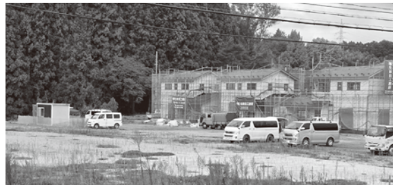
民間賃貸住宅の建設が進む旧小野高校平田校跡地
