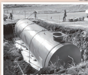
防火水槽設置事業 (打違内地内)
