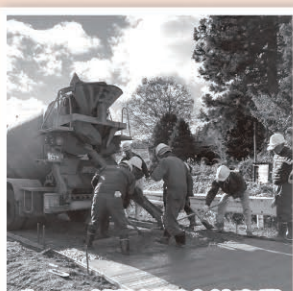
生コン舗装材料支給事業 (左鍬内地内)
