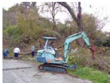
支障木伐採の様子
