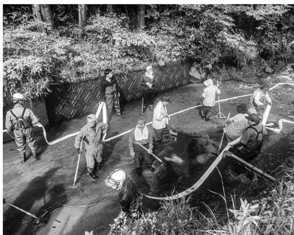
乙空釜浄水場の取水堰の砂払いが5月25日に行われました。この作業は乙空釜川からの表流水を効率よく汲み上げるために、取水堰に溜まっている砂を取り除くものです。
