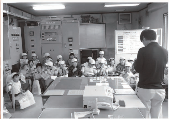
蓬田小学校「コンピュータで管理されているんだね」
