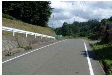
②空釜 (配水池下)
