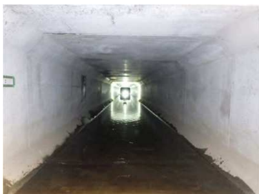
133号 ボックスカルバート内況（大河原地区）
