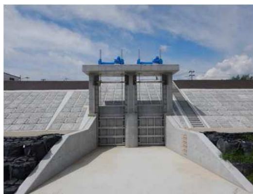
石塚排水樋門（大河原排水区）
