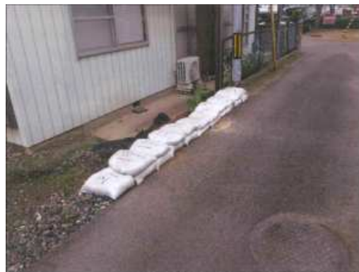
図 13.7 土のうの設置（郡山市）
