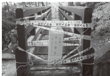
山鶏滝の橋の現状
