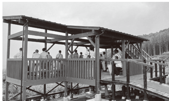
(新設された、あじさい園展望デッキを視察)
