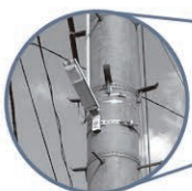
LED防犯灯を電柱に設置
