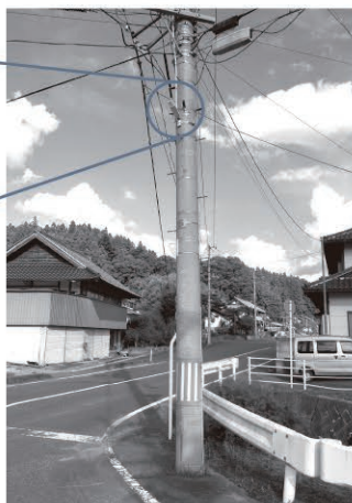
LED防犯灯を電柱に設置
